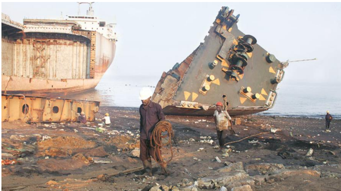
Slika 19. Rezanje sekcija na plaži u Bangladešu [18]
