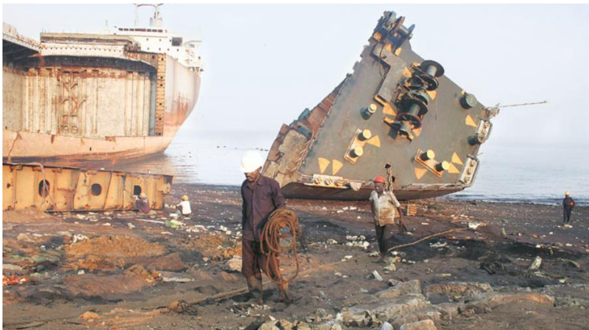
Slika 19. Rezanje sekcija na plaži u Bangladešu [18]
