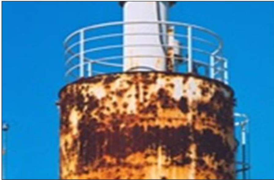
Slika 1. Opća korozija
