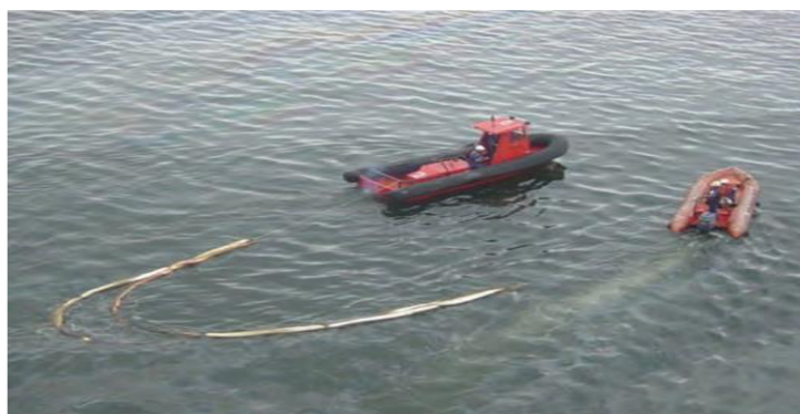
Slika 12. Postavljanje upijača na otvorenom moru [21]
