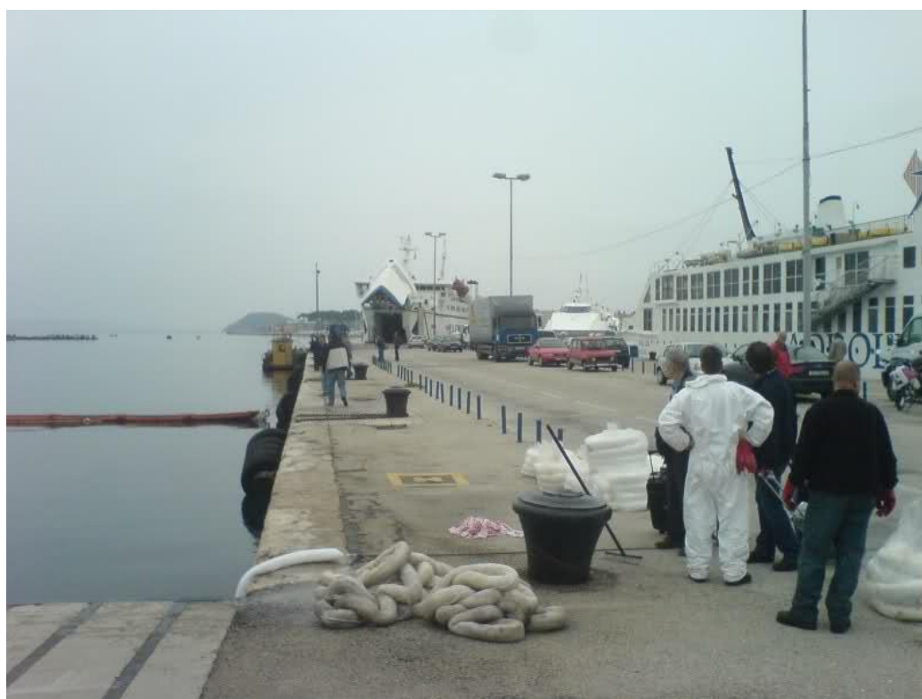
Slika 18. Sanacija izljeva i kobasice s upijačima [9]
