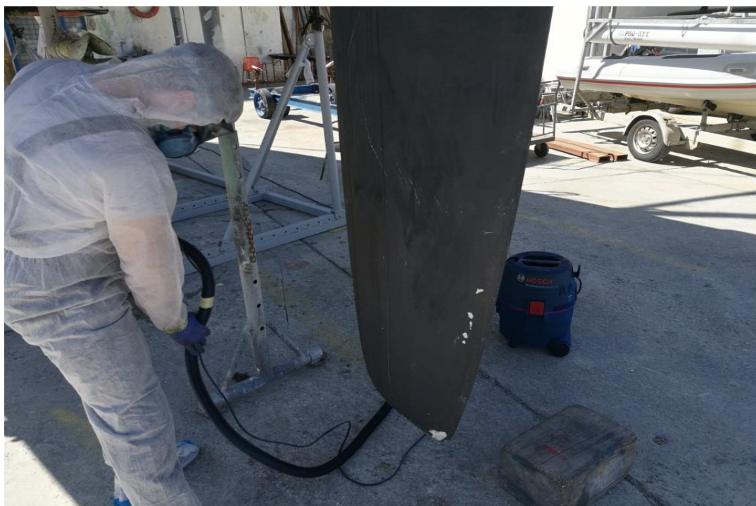
Slika 2. Brušenje s prikladnom opremom
