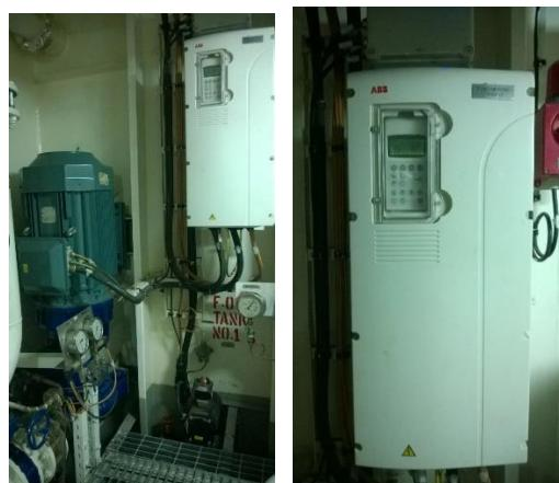
**Slika 52. Pumpa-elektromotor upravljan frekvencijskim pretvaračem**
