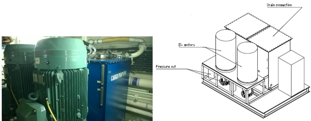
Slika 47. Hidraulični set za napajanje pumpi i agitatora [32]
