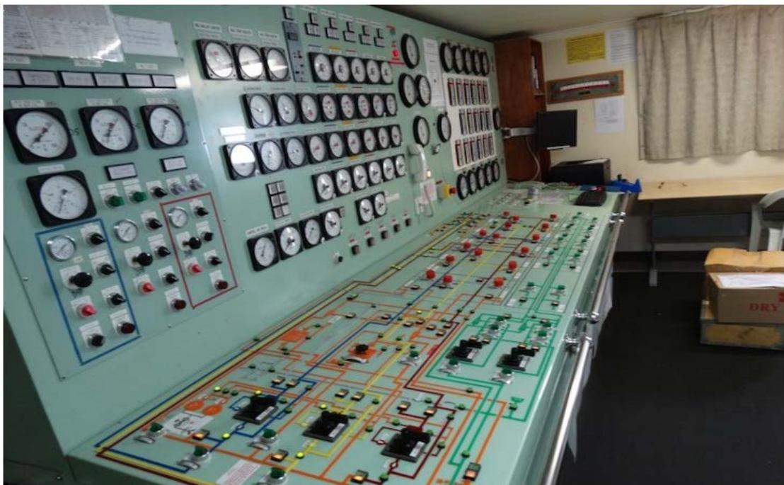
Slika 10. Ploča za upravljanje balastnom vodom [16]
