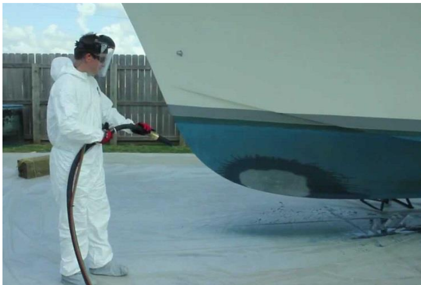
Slika 9. Čišćenje oplata broda mlazom abraziva [12]
