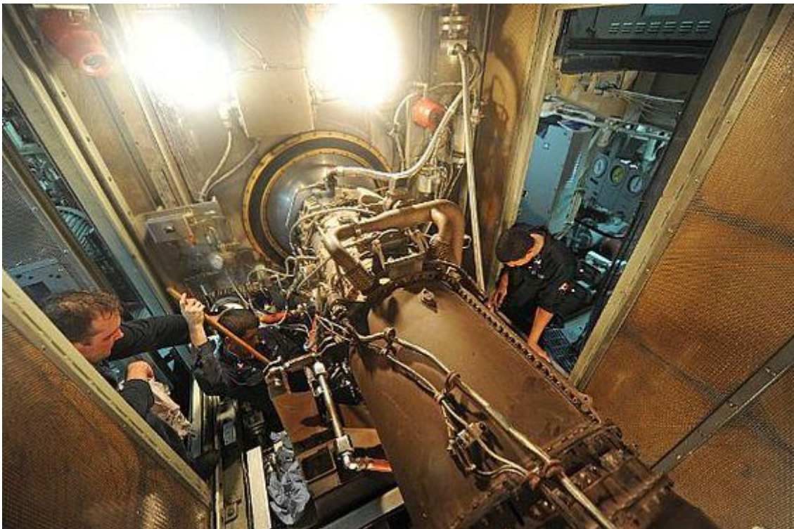
Slika 12. Servisiranje plinske turbine u brodskom postrojenju [12]
