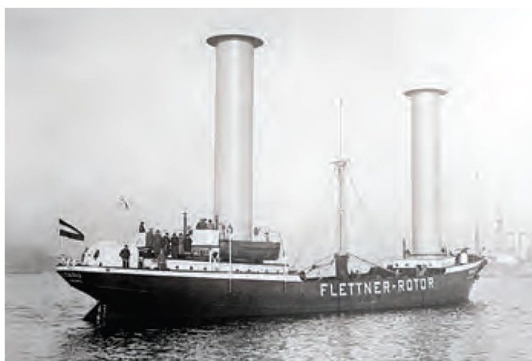
Slika 19. Brod Baden-Baden sa Flettnerovim rotorom [2]
