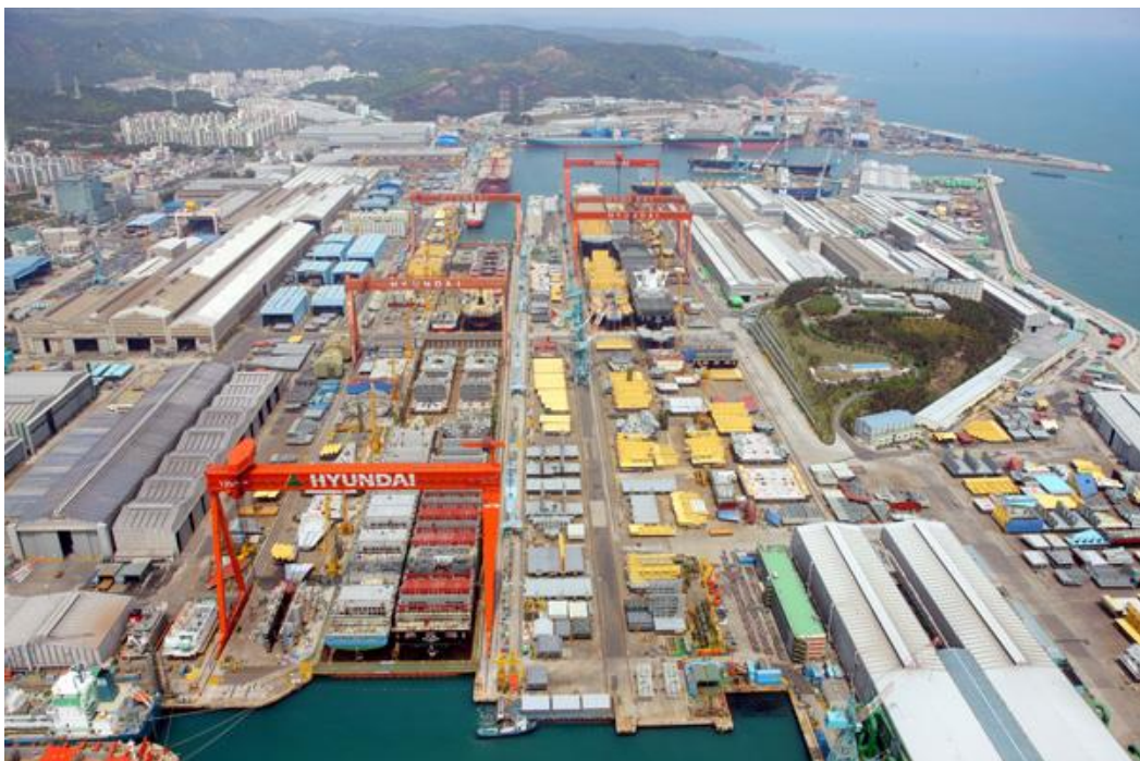
Slika 3.: Hyundai Ulsan brodogradilište [10]
