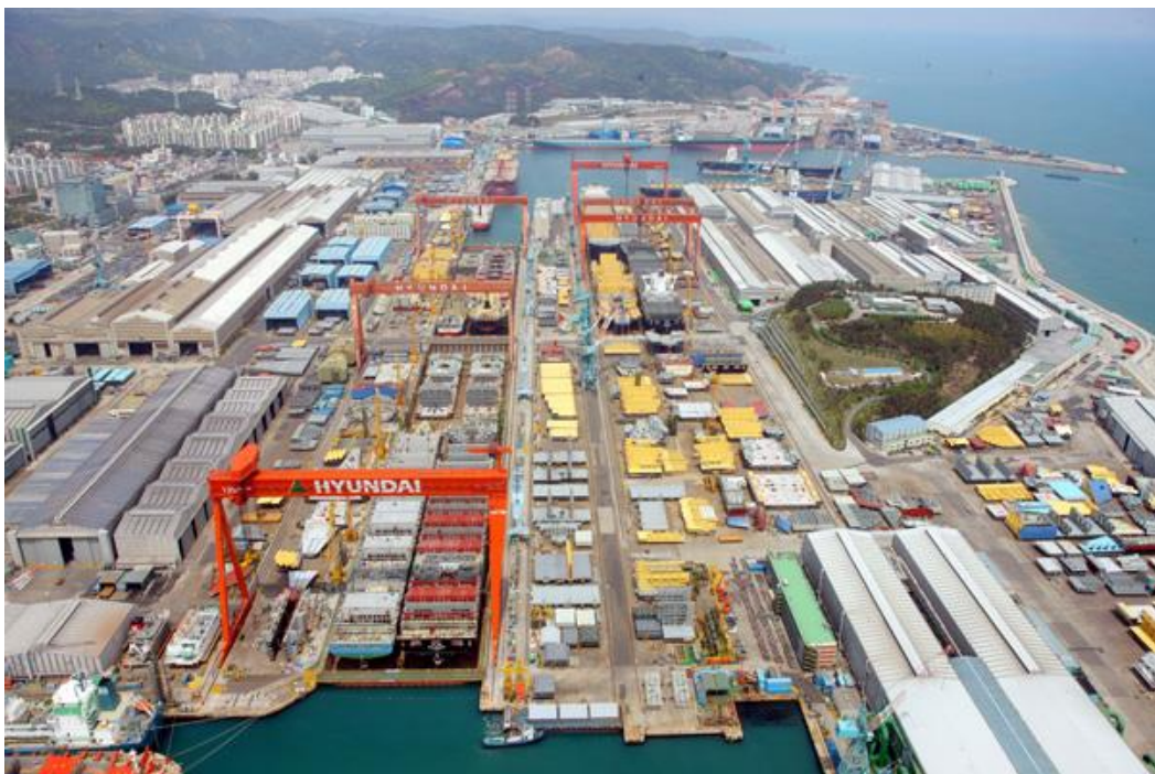
Slika 3.: Hyundai Ulsan brodogradilište [10]
