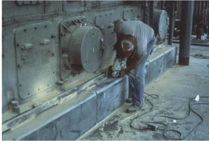
Slika 28. Naknadna obrada temelja od epoksidne smole [1]
