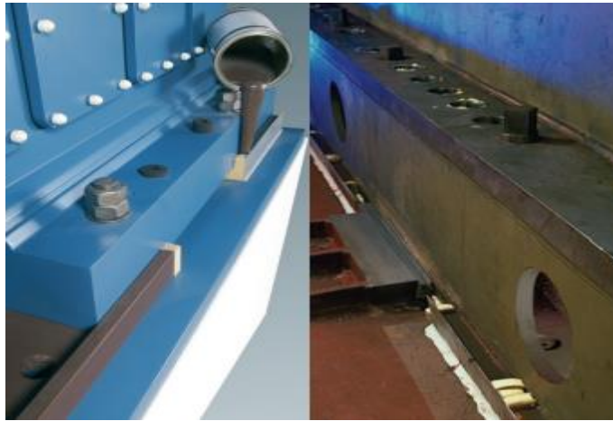
Slika 14. Temeljenje stroja smolom Epocast 36 [14]
