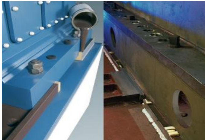
Slika 14. Temeljenje stroja smolom Epocast 36 [14]
