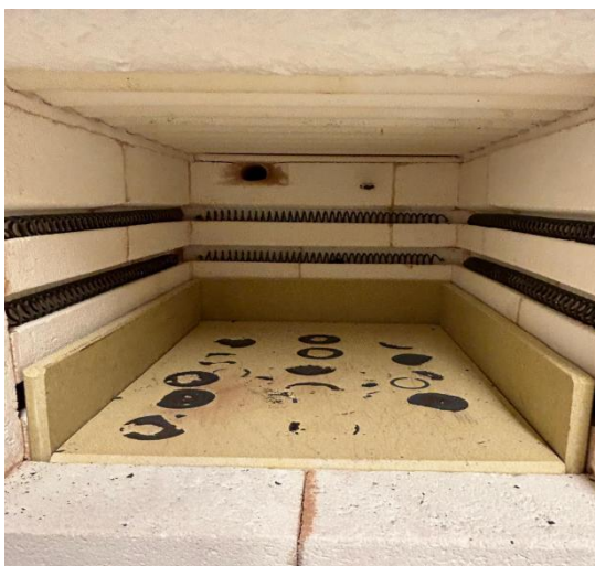
Slika 15. Unutrašnjost peći s keramičkom izolacijom i grijačima od kanthala.
