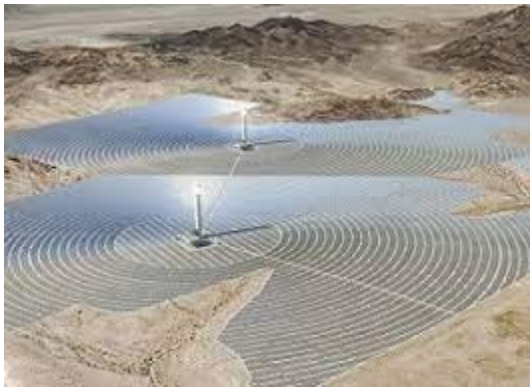
Slika 5. Najveća svjetska solarna elektrana u pustinji Mohava [5]
