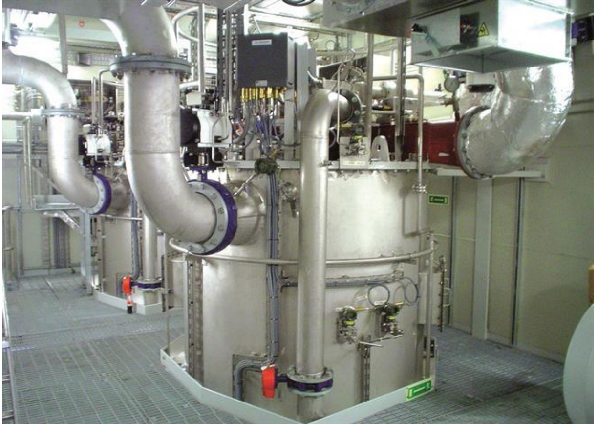
Slika 21 Generator inertnog plina
