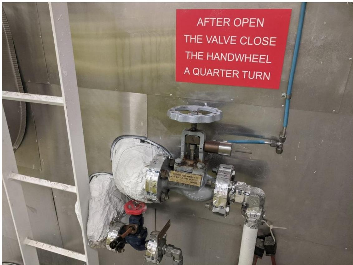
**Slika 13. Brzozatvarajući ventil s upozorenjem – Nakon potpunog otvaranja ventila pritvoriti ga za četvrtinu kruga.**
