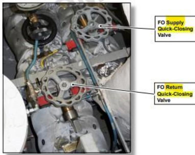
**Slika 3. Pneumatski upravljeni QCV na napojnoj i povratnoj liniji goriva za pojedini pogonski motor [3].**
