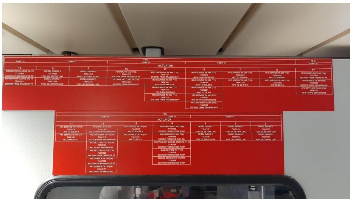
**Slika 15. Primjer daljinski zatvaranih uređaja brzozatvarajućim ventilima.**
