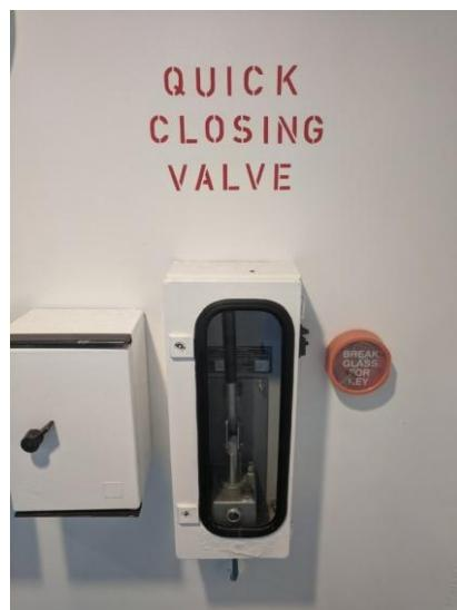
**Slika 4. Hidraulička pumpa za daljinsko zatvaranje brzozatvarajućeg ventila na sustavu goriva EDG.**
