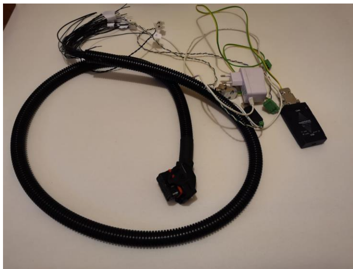
Slika 30. Pravilno spojen MOLEX CMC 98993 priključak s pretvaračima
