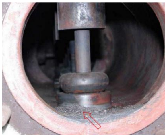
Slika 30. Kamenac u cjevovodu [23]
