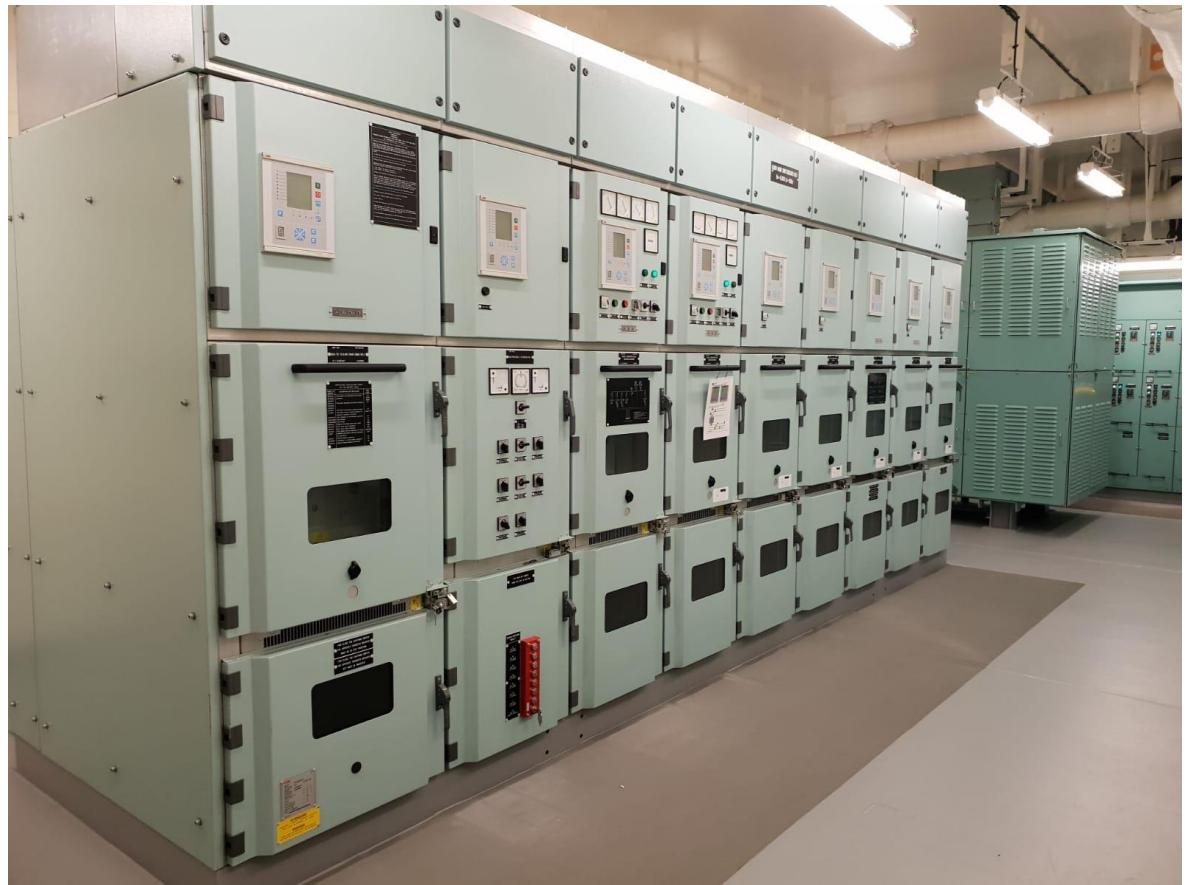
*Slika 17. Numerički zaštitni releji u visokonaponskom postrojenju*
