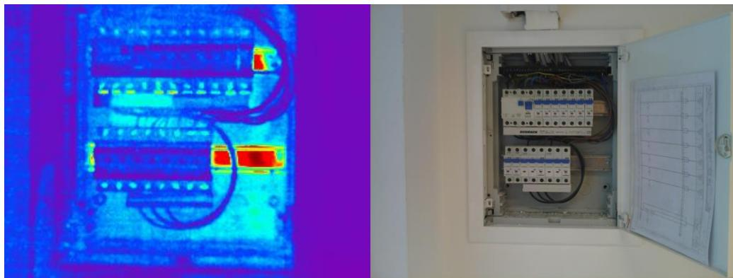
**Slika 14. Termografska slika i realna slika osigurača**
