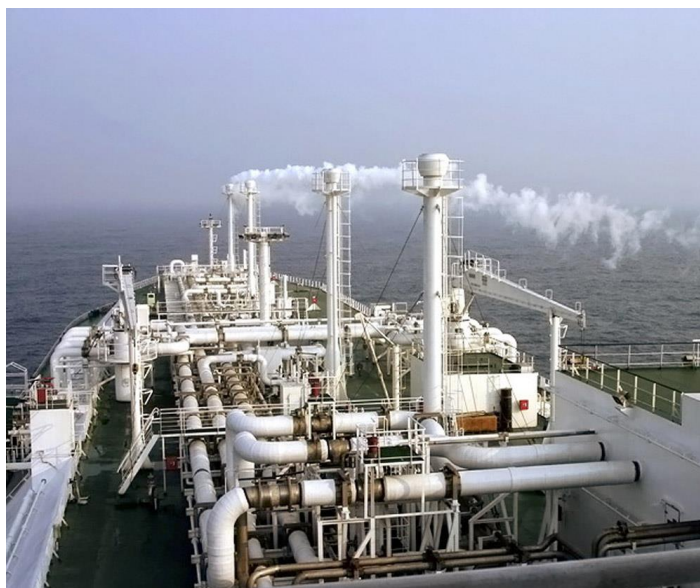
Slika 24. Ispuštanje BOG-a u atmosferu preko ventilacijskih jarbola [16]
