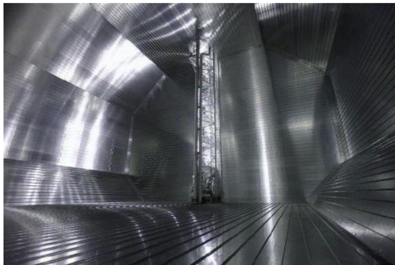
Slika 8. Unutrašnjost spremnika GT No.96 [6]
