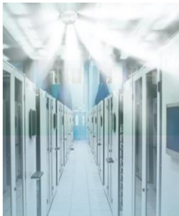
Slika 20. Ispuštanje plina „NOVEC 1230“ u računalnoj prostoriji
