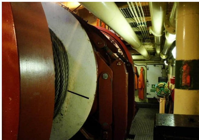
Slika 24. Kočnica na radnom vitlu za podizanje sidara [24]
