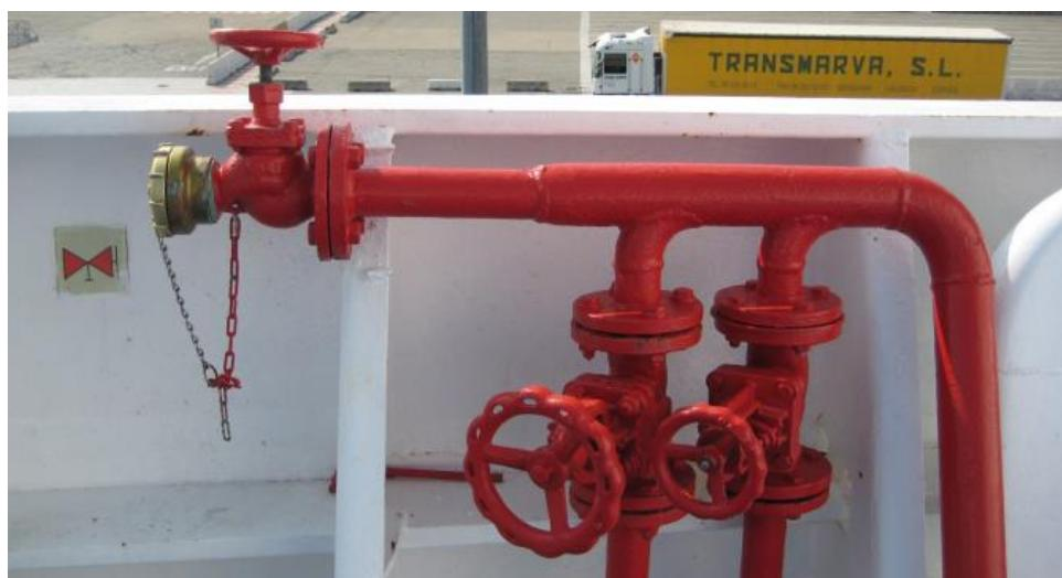
**Slika 6. Hidrant i protupožarni cjevovod [12]**
