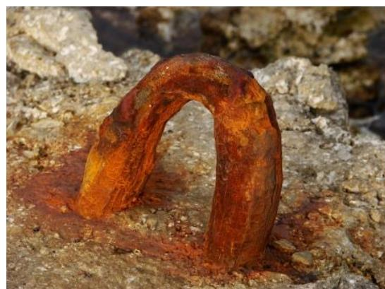
Slika 3. Progresivni gubitak materijala zbog erozije [6]
